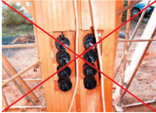
التنفيذ غير الصحيح في العارضة الهيكلية (يجب التحقق من ذلك).
