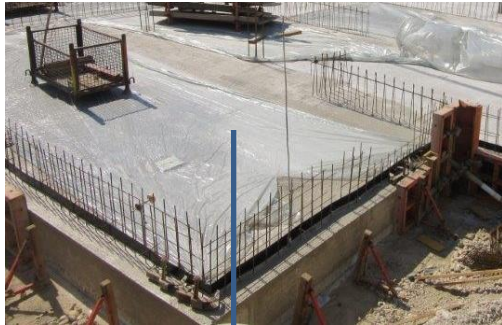
ألواح بلاستيكية على بلاط الأرضية الخرسانية
