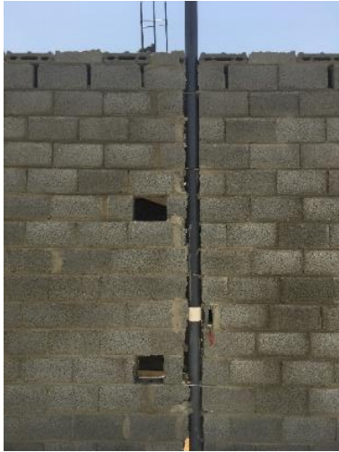
يظهر وجود حفر عبر المقطع العرضي للجدار بالكامل.
